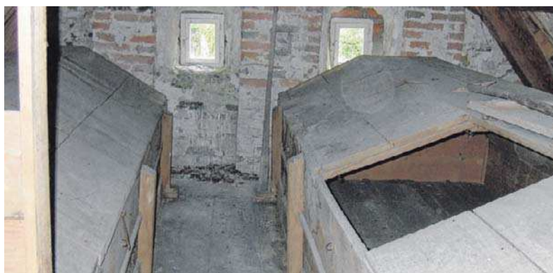
Durch Jahrhunderte befüllt mit „Pachtzins“ aus Hospitalbesitz: der Getreidespeicher auf dem Dachboden der Ölbergkapelle.
